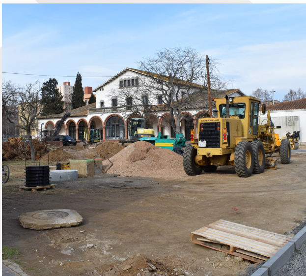
Obres de rehabilitació del parc hospitalari.
